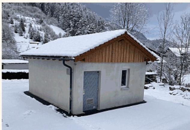
Die Bauarbeiten für das neue Pumpenhaus sind nahezu abgeschlossen. Lediglich die Fassade der Pumpstation sowie kleinere Sanierungsarbeiten am Niederbehälter müssen noch im Frühjahr fertiggestellt werden. Das neue Pumpenhaus wird als Schaltzentrale für das komplexe Wasserversorgungsnetz von St. Aegydt dienen.
