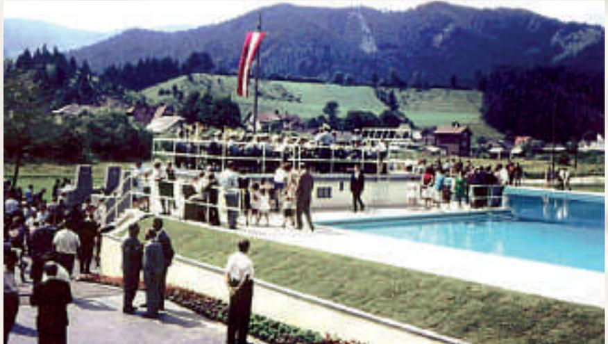
Kern der Anlage bildet das Sportbecken von 15 x 25 Metern und einer Wassertiefe von 1.85 - 3.50 Metern. 5 Schwimmbahnen, ein Ein-Meter-Brett und ein Drei-Meter-Turm erlauben auch Wettkampfanstaltungen. Das Nichtschwimmerbecken – 12 x 10 Meter groß – schließt im rechten Winkel an das Sportbecken an und wird von diesem durch ein Sicherungsseil getrennt. Westlich des Beckens dehnt sich die Ballspielwiese aus und ist von den Liege- und Sonnenplätzen vollständig isoliert.
